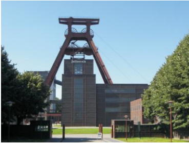
fig. 33_ Zollverein renew building
